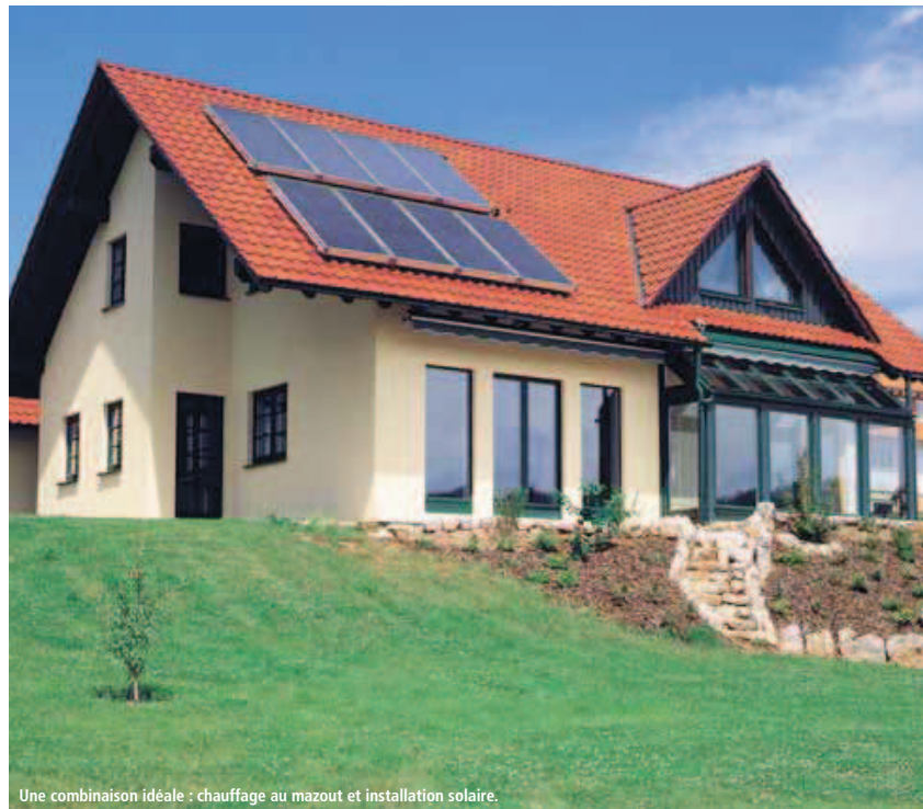
Une combinaison idéale : chauffage au mazout et installation solaire.
